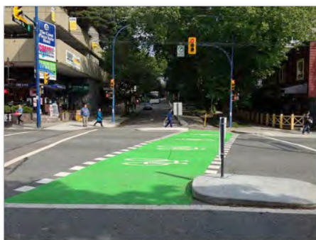
Exemple de traverses avec un marquage explicite
