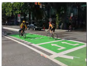
Exemple de traverses avec un marquage explicite
