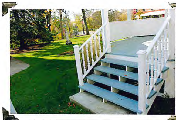
Galeries composées de planche de bois
