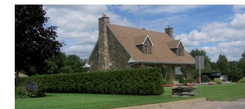
Chemin de la Rivière-du-Sud (maison néoquébécoise)
